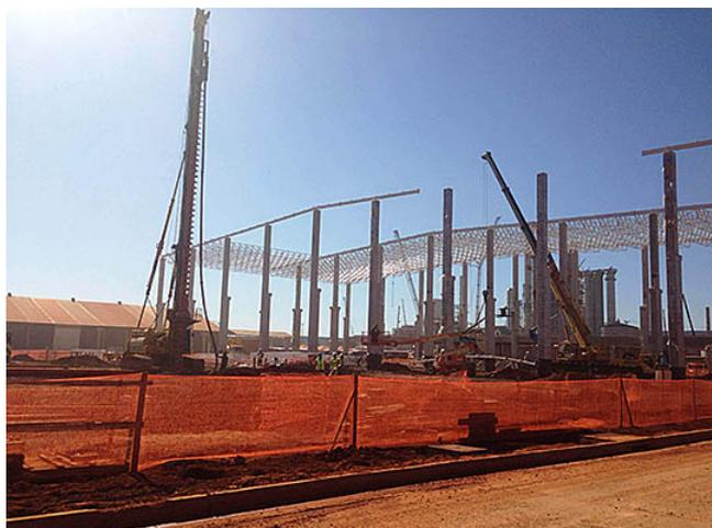
As estacas dos prédios da administração, do galpão do almoxarifado, da oficina mecânica e dos depósitos de gases já foram instaladas
