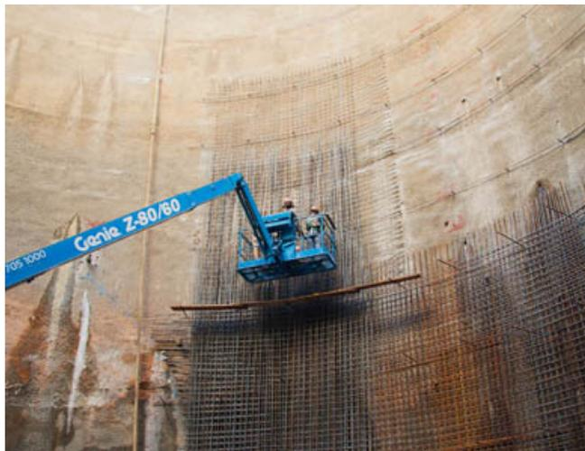
Paredes do poço, com 32m de profundidade e 22m de diâmetro, foram executadas com fôrmas deslizantes
