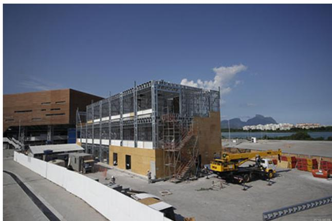
FRAMECAD – empresa que desenvolve sistemas de construção estrutural em Light Steel Frame – tem sua tecnologia usada na construção da TV Tower, conjunto de estúdios onde acontecerão as transmissões ao vivo das Olimpíadas
