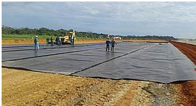
Aplicados em obras viárias, de geotécnicas, hidráulicas, costeiras e de projeção ambiental, os produtos desempenham funções de filtração, drenagem, impermeabilização, entre outras
