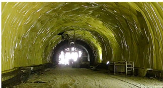
Após uma série de pesquisas e testes, a Cipatex®, fabricante de revestimentos sintéticos, passa a oferecer ao mercado geomembranas de PVC para impermeabilização de túneis e estações de metrô. Com espessura de 3 milímetros, o material conta com alta tecnologia, resistência ao envelhecimento e às influências do meio ambiente, retardante de chamas e excelente estanqueidade.
