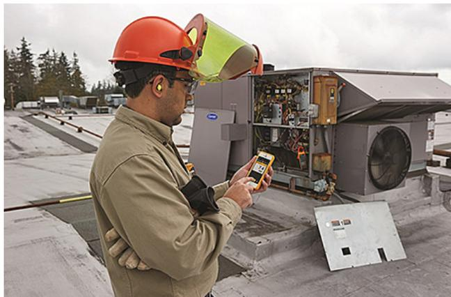
O novo medidor Fluke 902 FC permite que os técnicos de HVAC criem relatórios e colaborem com membros da equipe em tempo real, diretamente do local de trabalho. As medições são transmitidas via Wi-Fi para o aplicativo Fluke Connect em smartphones ou tablets, e são automaticamente armazenadas na nuvem.
