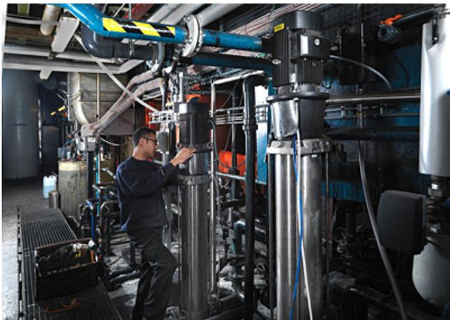
Nada menos que 10% da energia mundial é consumida por motores que equipam sistemas de bombeamento. Focada na otimização energética das bombas instaladas no cliente, a Grundfos está lançando o serviço Pump Audit, composto por um kit que contempla sensores de medição, temperatura, vazão e pressão. Com ele, é possível dimensionar o consumo energético real e ideal, ajudando a poupar energia e custos ao cliente final.
