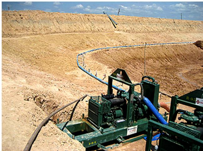
Solução permite cravação mecanizada, com a ativação de 30 e 50 ponteiros/dia, instaladas por um processo de encamisamento com auxílio de minicarregadeira (bobcat)
