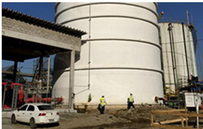
Reservatórios gigantes de compósitos em PRFV substituem com vantagens os similares de concreto e aço vitrificado em aplicações no setor de saneamento
