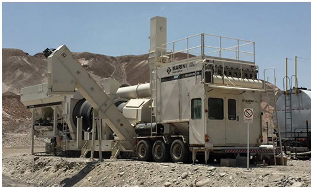
Pacote BOMAG MARINI em obra itinerante no Peru
