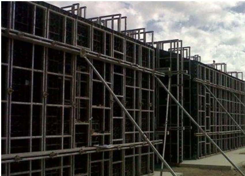
Formas plásticas são utilizadas em obras do estádio Beira-Rio
